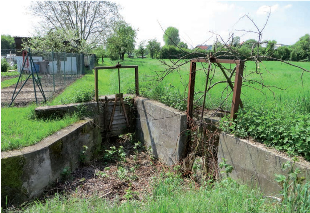
Historische Schließanlage am Oberlauf im Oberbruch/Markgräfer Bruch des Alten Kraichbaches/Seitengraben, bis in die 1960er Jahre in Betrieb.
