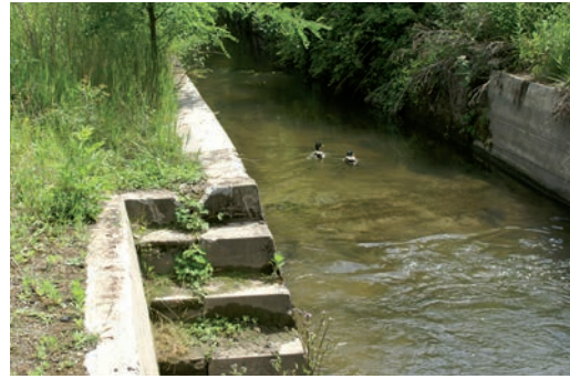
Treppe zum Mühlkanal
