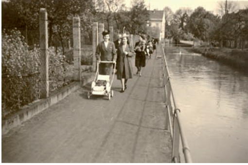
Zwischen Karlsruher Straße und Kaiserstraße früher
